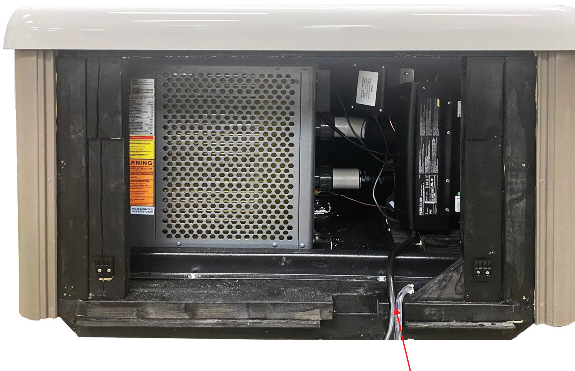
Strömsladd och dräneringsslang i utskuret område
